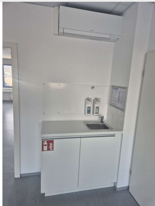
Büro2 Spüle und Durchgang
